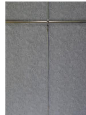
▲ Zusätzliche Dachstangen stabilisieren die Dachfläche.
